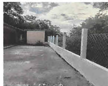
Foto 6: muro perimetral reparado
