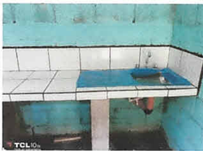
Foto 3: Instalacion de azulejo y lavatrastos
