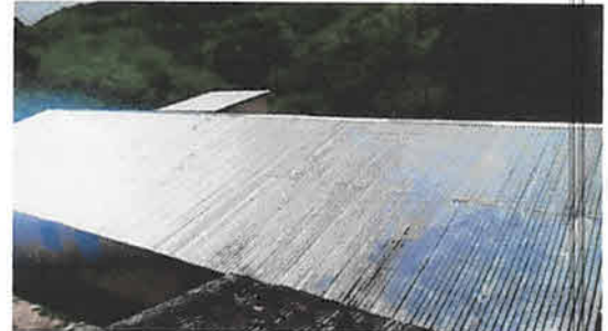
Foto 2: Instalacion de lamina
