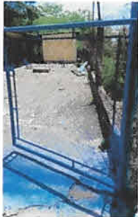
Foto 1: Ilijado y pintura de porton
